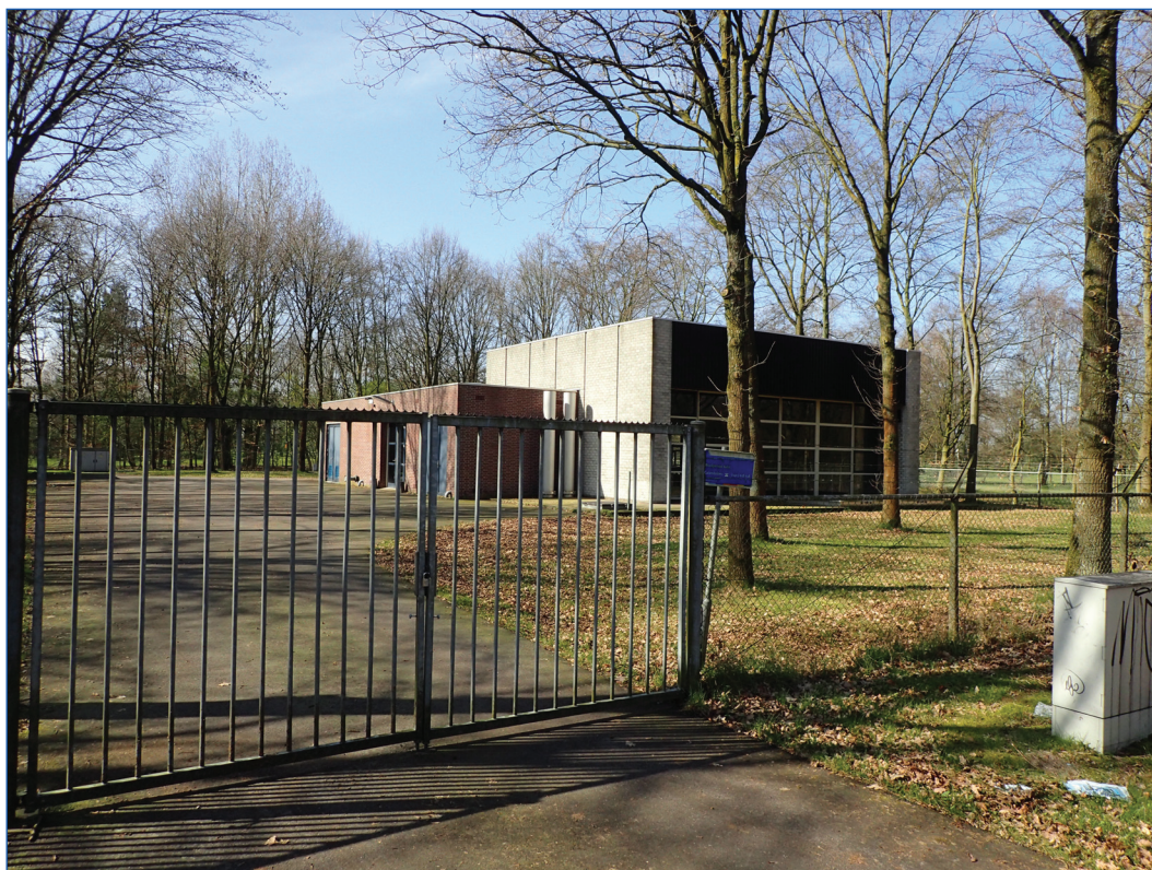
Figuur 3.9. Het rioalgemaal 'Aalst' is gebouwd in een droge kamptginning, in een gebied dat de facto tot de ontginningen van Aalst gerekend dient te worden (foto: Luuk Keunen, 23 maart 2017).
