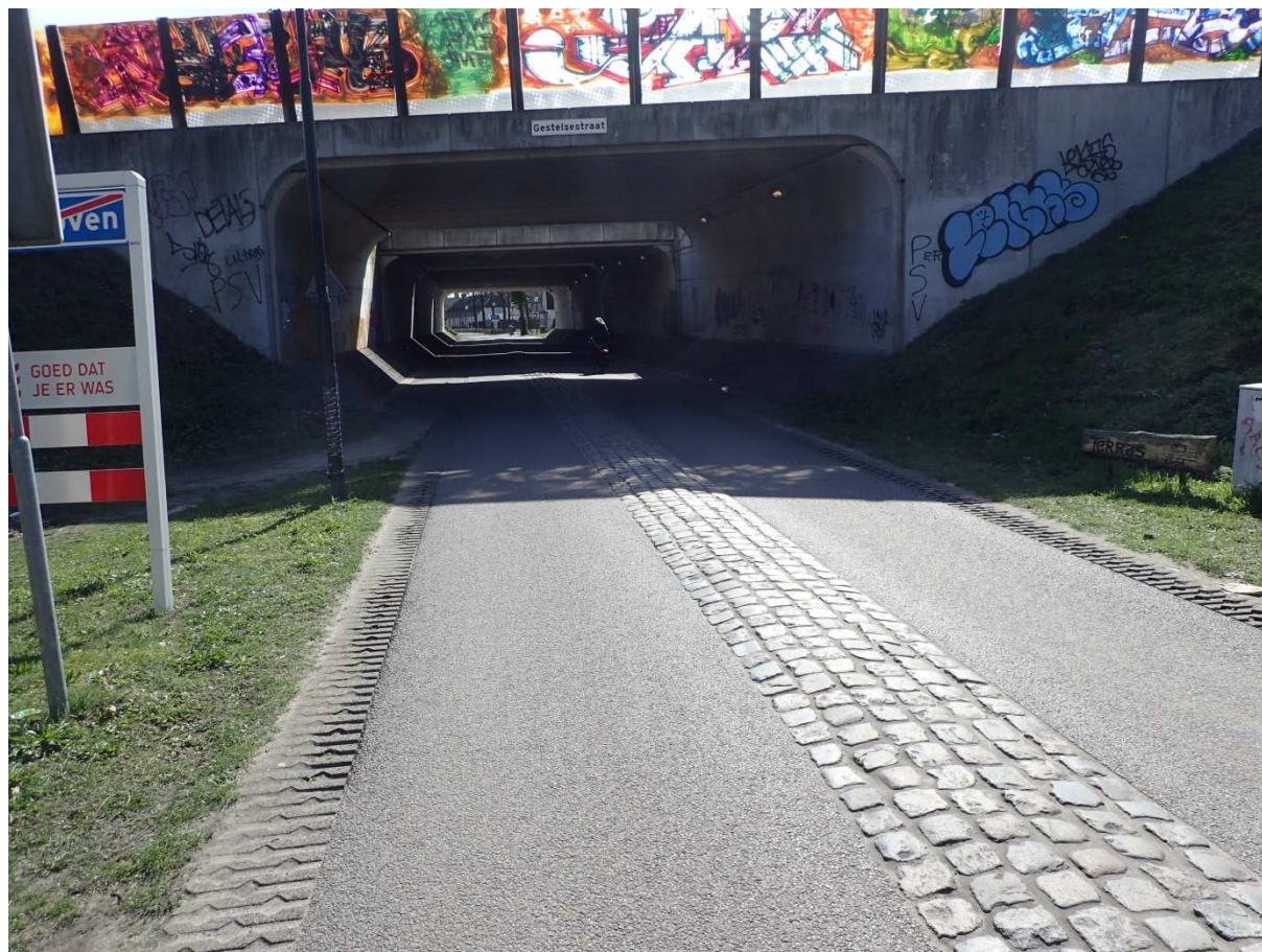
Figuur 43. Het viaduct van de N2/A2 over de Velddoornweg, de verbinding tussen Gennepe en het dorp Aalst (foto: Luuk Keunen, 23 maart 2017).
